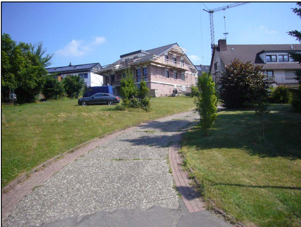
Abb. 2: Neubau eines Einfamilienhauses kurz vor der Fertigstellung (vergleiche Abbildung 1: Fotostandort 1).
